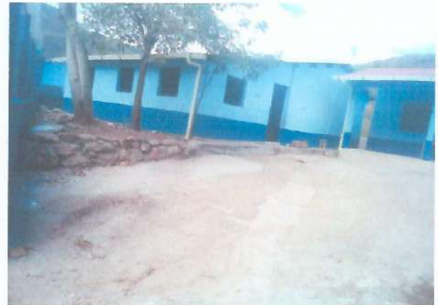
Foto 2: Mejoramiento de losa de patio.
