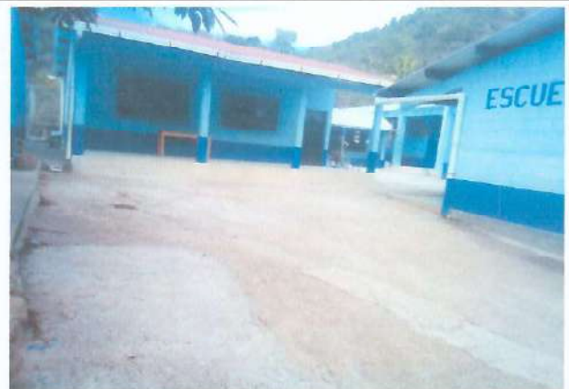
Foto 4: Mejoramiento de losa de patio.
